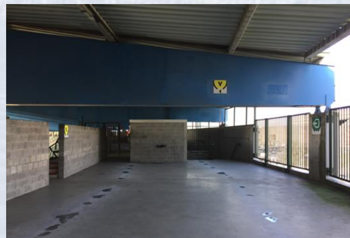
Pourtour pour le public au niveau de la 2 e couronne de la Tribune 2
