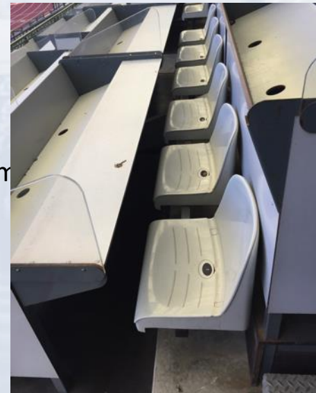
Espace média trop restreint (profondeur d'1,5 rangée au lieu de 3)
