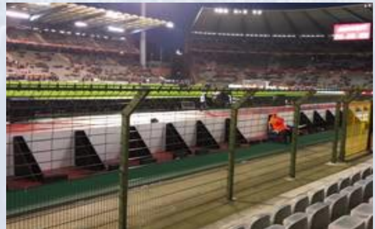
Vue des 8 premières rangées de la tribune environ
